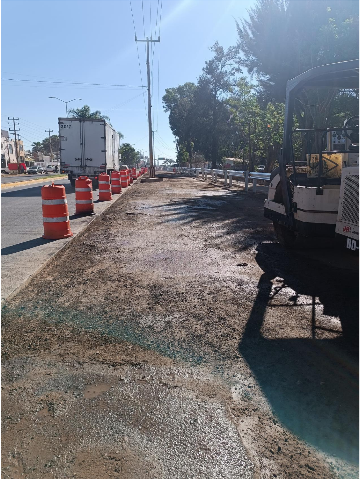
PAVIMENTACIÓN CON CARPETA ASFÁLTICA EN LATERAL JOSE GONZALEZ CARNICERITO CON AV. JACARANDAS EN CABECERA MUNICIPAL, ENTRE LAS CALLES JACARANDAS Y GARDENIAS EN EL MUNICIPIO DE TEPATITLÁN DE MORELOS, JALISCO.
